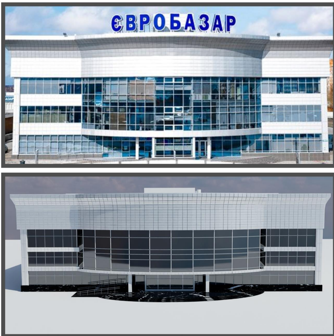
Рисунок 3.2 – Порівняння центрального входу Євробазару
