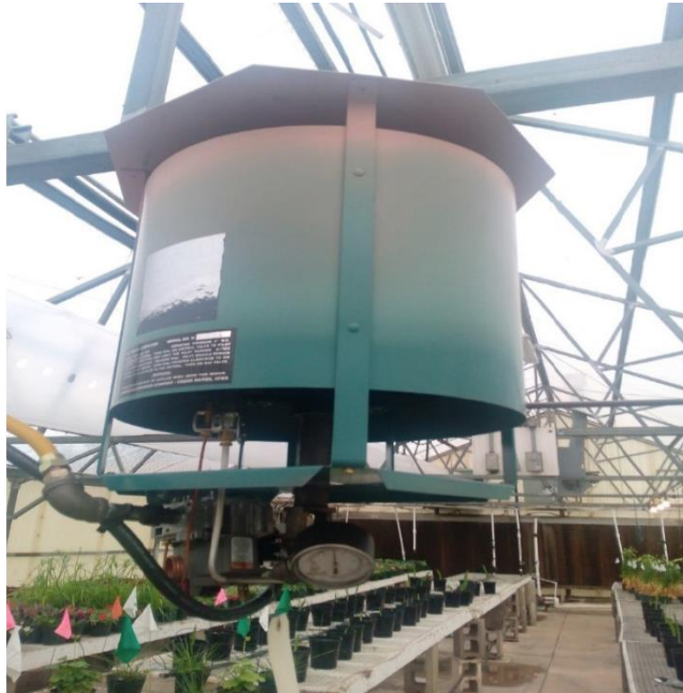
Рисунок 2.6 – Генератор \text{CO}_2 для комерційної теплиці, що може працювати як на пропані так і на природному газі [9, 10, 15]
