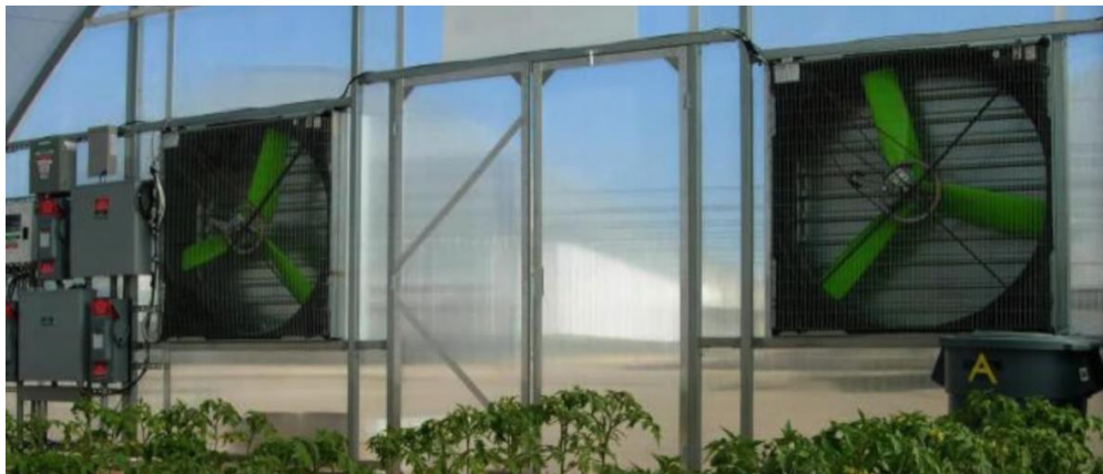
Рисунок 1.6 – Вентиляторна система охолодження теплиці [6]
