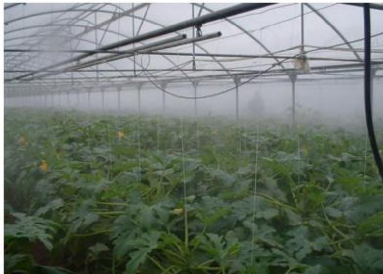
Рисунок 2.2 – Система вентиляції та туманоутворення
