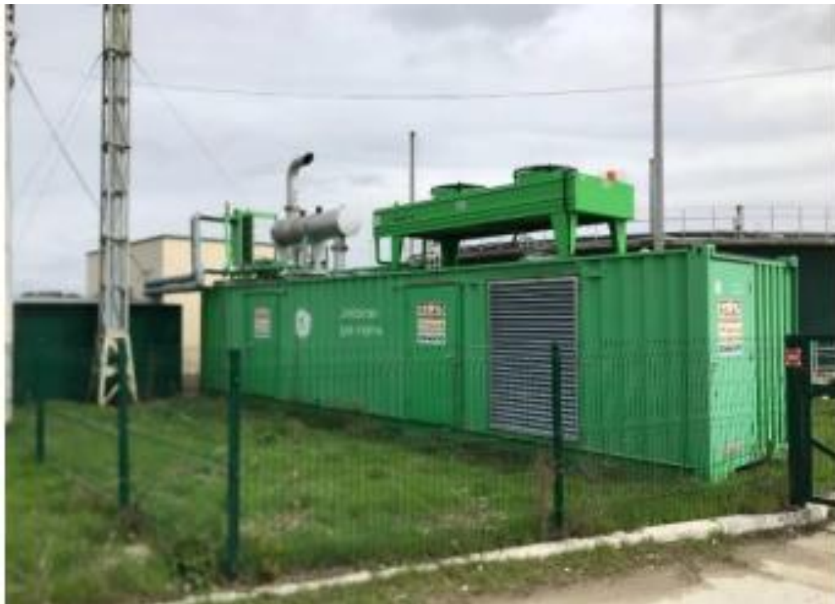
Рисунок 2.16 – Когенераційна установка
