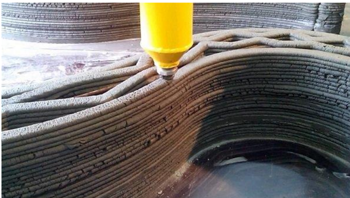
Рисунок 2.1 – Зведення будівлі шляхом накладання послідовних шарів бетону за допомогою 3D-принтеру [33].
