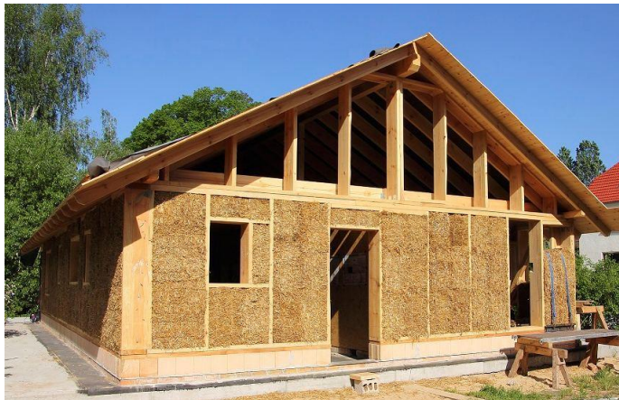
Рис. 2.6. Процес зведення екобудинку з соломи за каркасною технологією.
